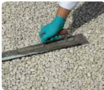
Glätten und verdichten
