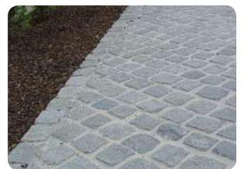
Fertig verfugte Fläche
