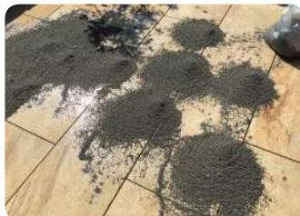
Mörtel portionsweise aufbringen
