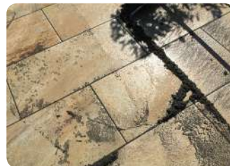
Mörtelreste entfernen
