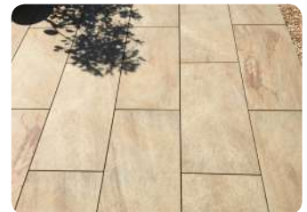
Fertig verfugte Fläche
