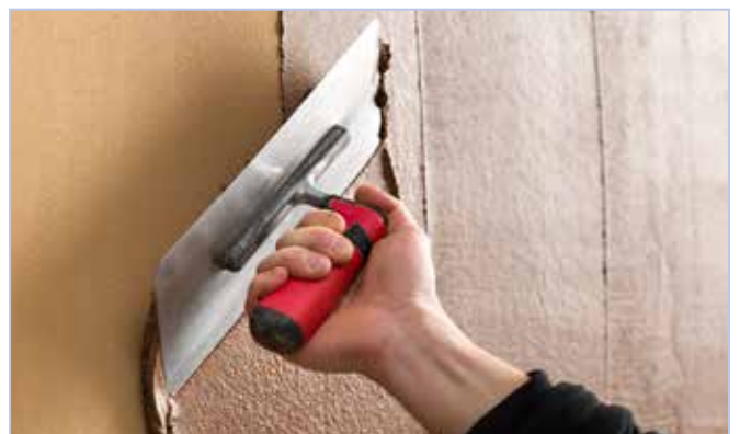
8. conlino Lehm-Edelputz auftragen
