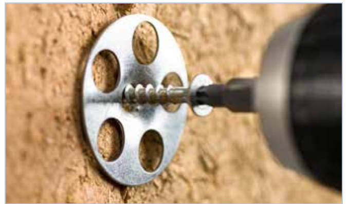
4. Befestigen, z. B. mit Haltetellern
