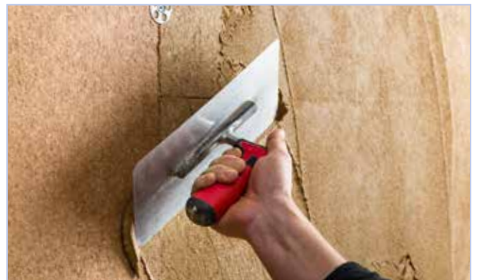
6. Lehm Klebe- und Armierungsmörtel aufziehen
