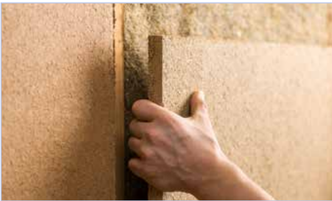
3. Platten hochkant ansetzen; auf Fugenversatz achten
