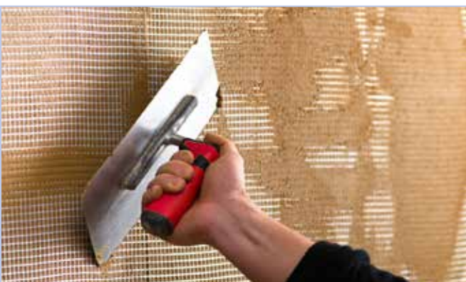
7. Gewebe einbetten und überdecken
